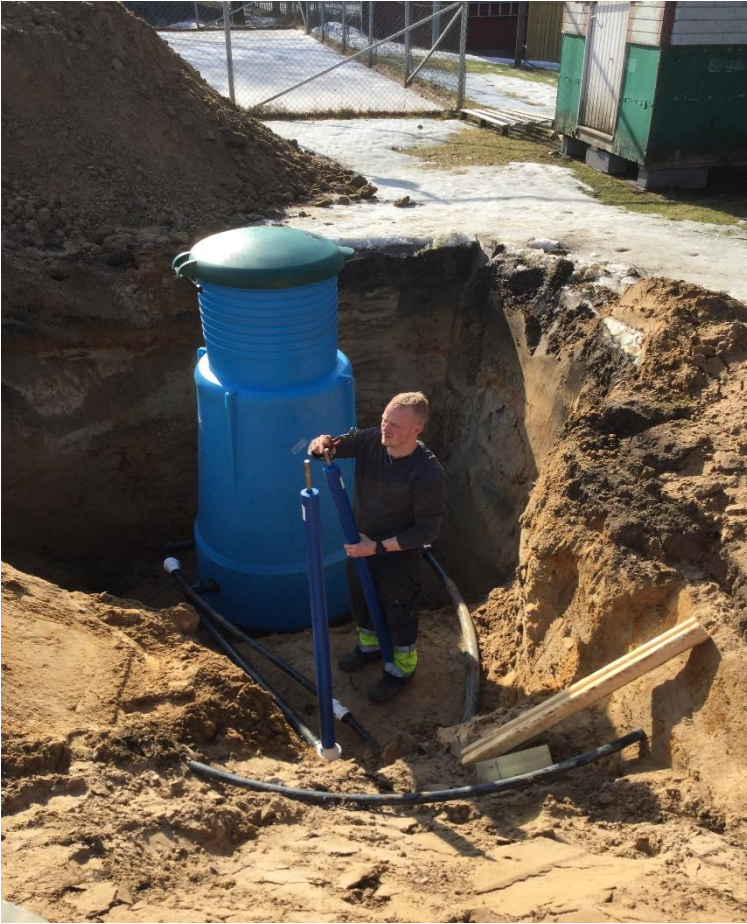
Mittakaivon asennus, Tammisaaren tenniskenttä, Robin Lindholm
