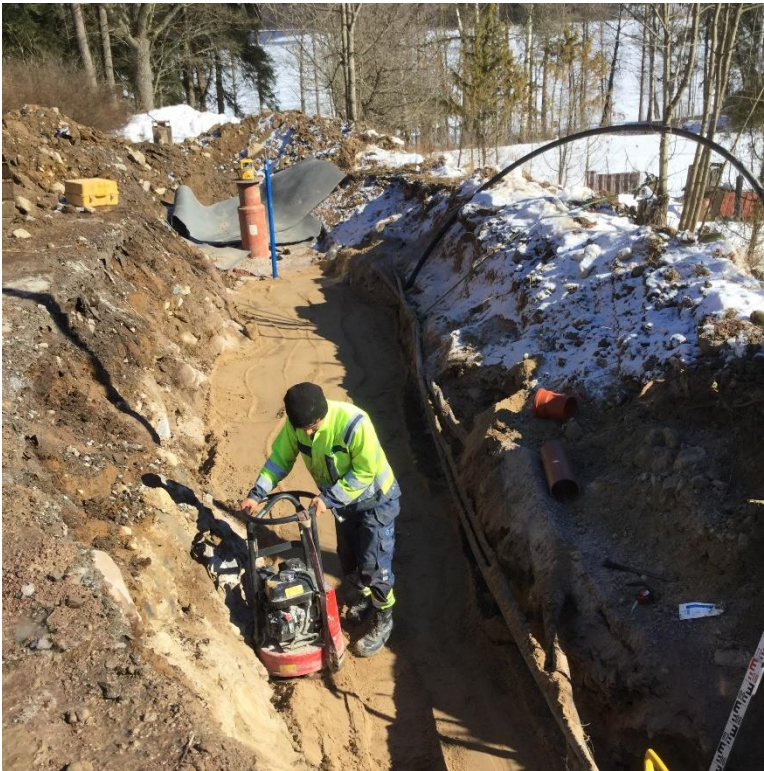
Mustion Byggarsintien laajennustyö, Jonny Lehtinen
