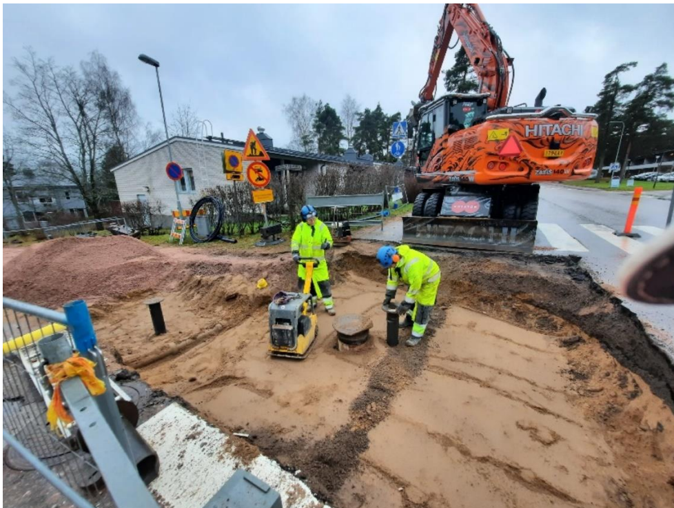
Kuva 4 Jussi ja René saneeraamassa johtoja Klockarsinkadulla, Karjaa
