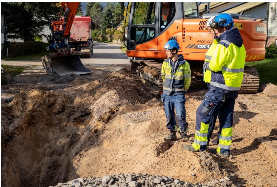
Kuva 1 Jonny, Guy ja Robert kunnostamassa johtoja Tuomarinkadulla, Karjaa
