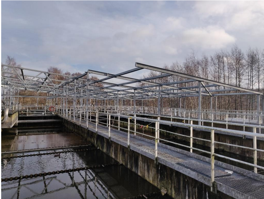
Kuva 6 Skeppsholmenin prosessialtaiden seinien ja katon rakentaminen on käynnistynyt
