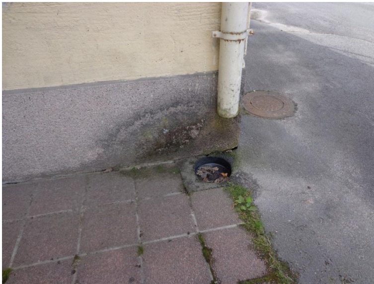
Kuva 73. Vedenpoistoa tulisi parantaa lähes jokaisessa rakennuksessa
