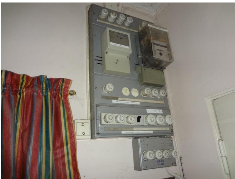
Kuva 98. Kiinteistön sähköpääkeskus ja asunnon B ryhmäkeskus tulee uusia sähköverkon kokonaissaneerauksen yhteydessä.
