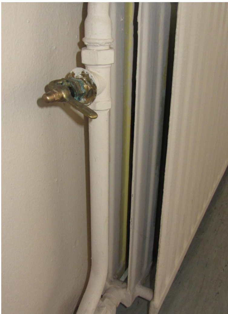
Kuva 6. Alkuperäinen patteriventtiili
