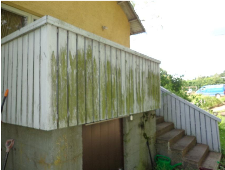
Kuva 94. Myös kaikki puuosat tulee maalattavaksi / vaihdettavaksi.
