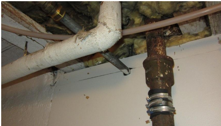
Kuva 96. Valurautaviemärissä vuotokohdan paikkaus
