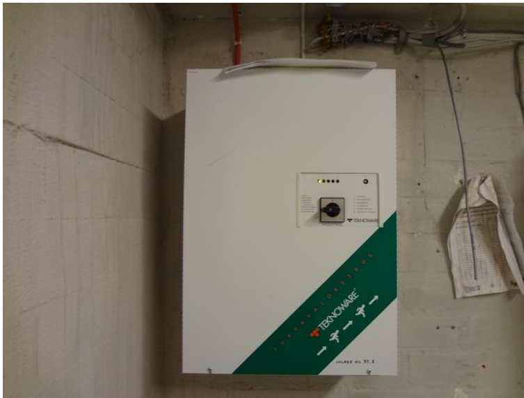
Kuva 25. Rakennuksen 1 turva- ja poistumistieopasteet ovat hyväkuntoisia – osa opasvalaisimista tulee uusiksi nykyisen standardin mukaisiksi.
