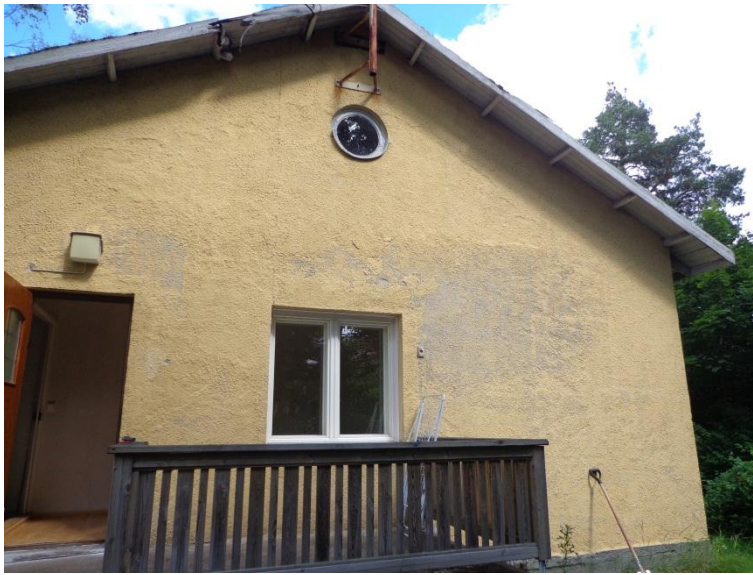
Kuva 93. Seinäpinnat tulisi maalata ja vauriot korjata huolellisesti.
