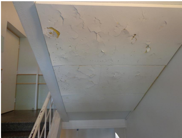
Kuva 74. Akustiikkalevyt tulisi vaihtaa lähinnä viihtyvyyden vuoksi.
