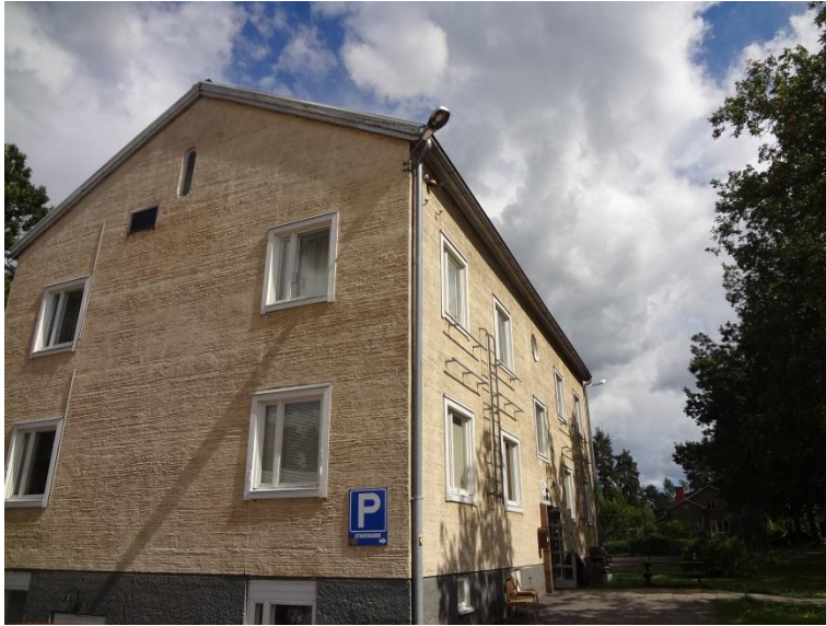
Kuva 103. Alueen ja kiinteistöjen ulkoseinävalaisimet ovat teknisen käyttökänsä lopussa ja vaikeasti huollettavia (ei rakennus 6).
