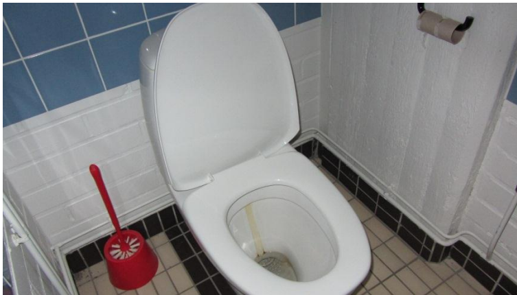
Kuva 54. Todella suuri osa wc-istuimista vuotaa
