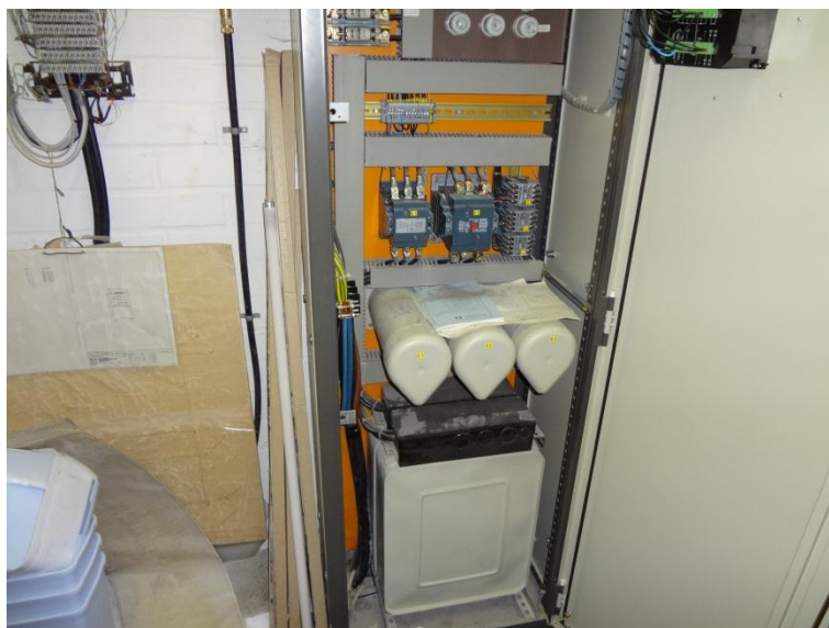
Kuva 56. Nousukeskukseen on liitetty 125 kVar kompensointiparisto.
