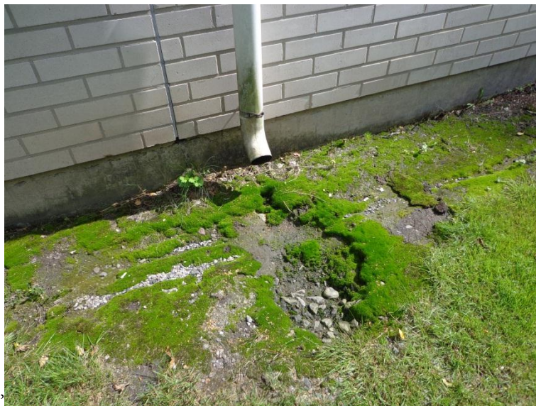
Kuva 52. Vedenpoisto tulisi järjestää huolellisesti.
