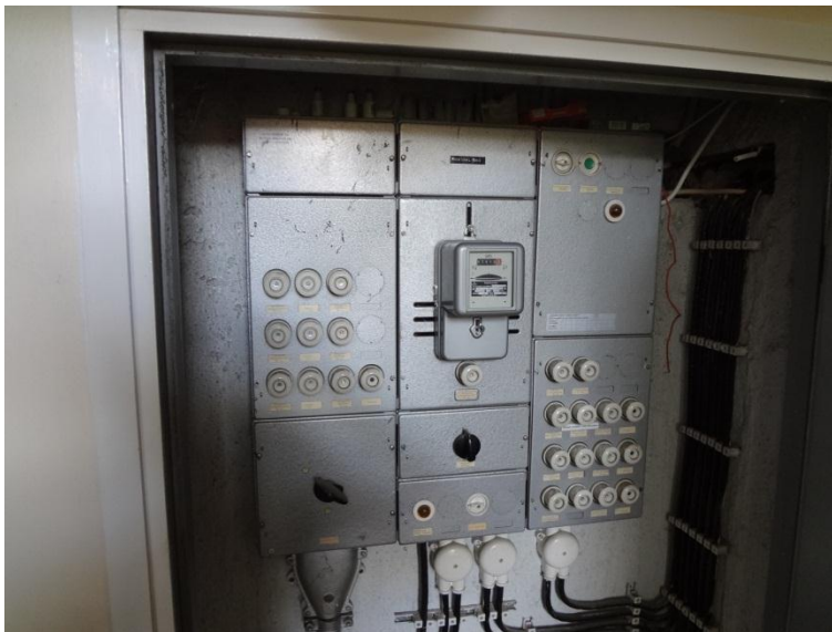
Kuva 45. Nousu- ja ryhmäkeskukset tulee uusien sähköverkon kokonaissaneerauksen yhteydessä.
