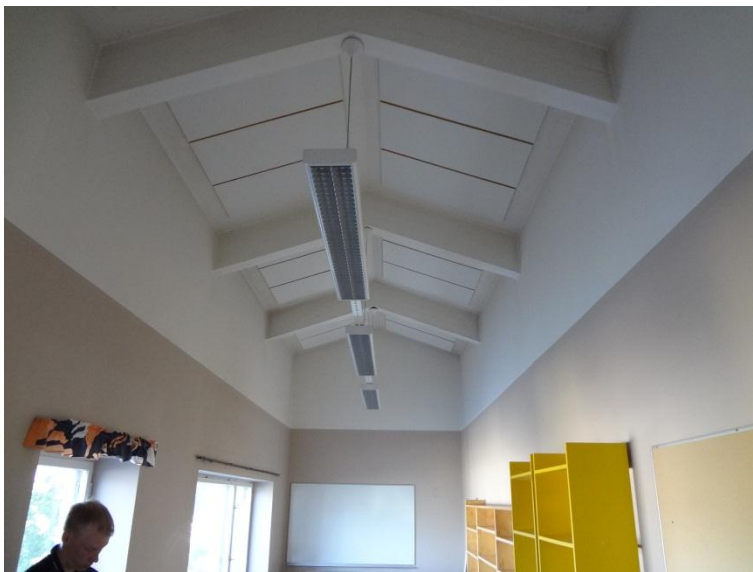
Kuva 11. Osa valaistusasennuksista on uusittu
