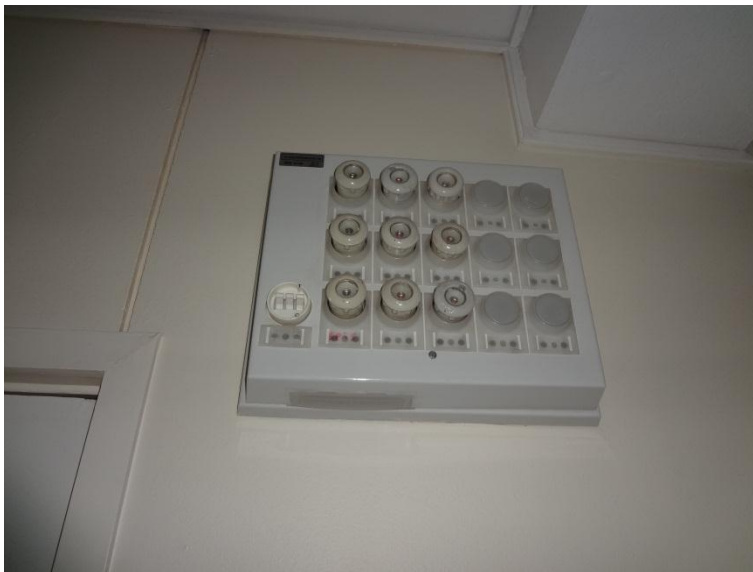
Kuva 68. Asuntotilat 2-kerroksessa ovat normaalikuntoisia, mutta ne on suositeltavaa saneerata 1-kerroksen tasoon ja 5-johdinjärjestelmän mukaisiksi.
