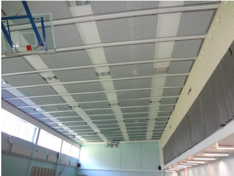
Kuva 60. Liikuntasalin valaisimien uusimiseen tulee varautua - elohopeahöyrylamppujen saatavuus loppuu vuonna 2015.
