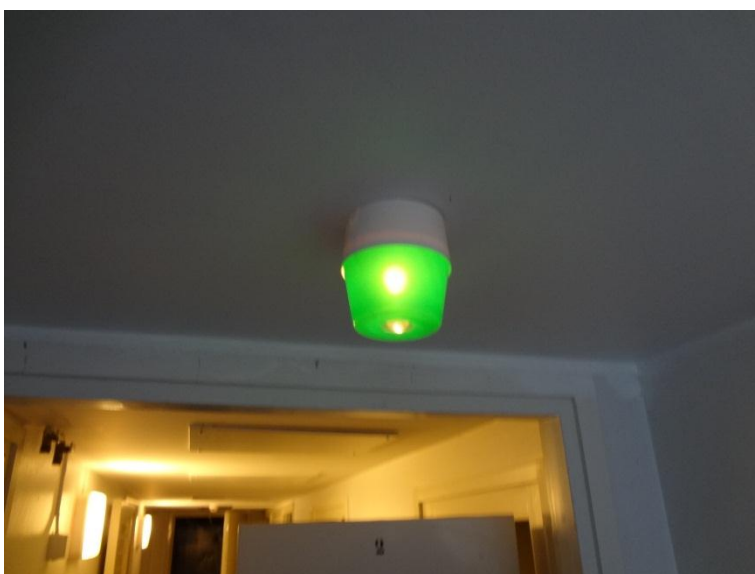
Kuva 37. Osa opasvalaisimista tulee uusia nykyisen standardin mukaisiksi mikäli rakennusosassa tehdään rakennuslupaa edellyttäviä toimenpiteitä.
