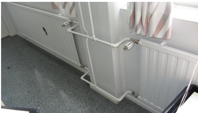
Kuva 33. Alkuperäisiä teräslevypattereita
