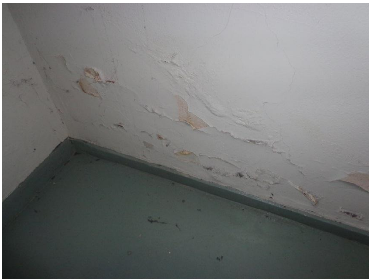
Kuva 31. Kosteusvauriojälkiä kuivaushuoneessa
