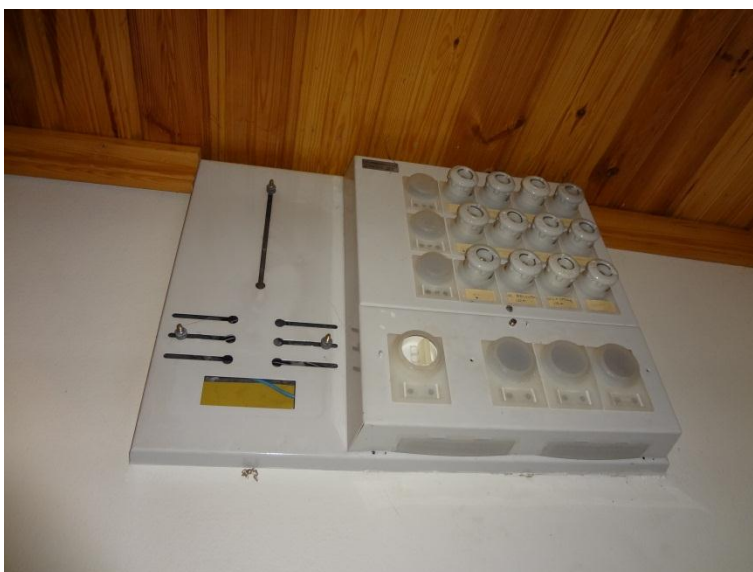
Kuva 86. Asunnon A ryhmäkeskus on peräisin arviolta 1970 luvulta, ja tulee uusia sähköverkon saneerauksen yhteydessä.
